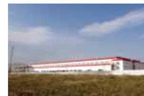
Строительство регионального распределительного центра «Магнит» в Нижегородской области
