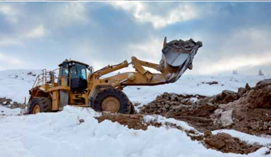
Колесные погрузчики Cat 988H (сверху) и автогрейдеры 16H играют важную роль в устройстве и поддержке 150 км внутрикарьерных дорог.
