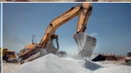
КМ 152 Гусеничный экскаватор складировывает щебень для его дальнейшего распределения
