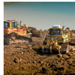
На рабочей площадке гусеничные тракторы D6, входящие в парк из 40 машин Cat.
