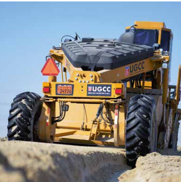
◀ Cat RM300 одновременно добавляет воду и перемешивает песок, позволяя получить оптимальную влажность для дальнейшего уплотнения.
