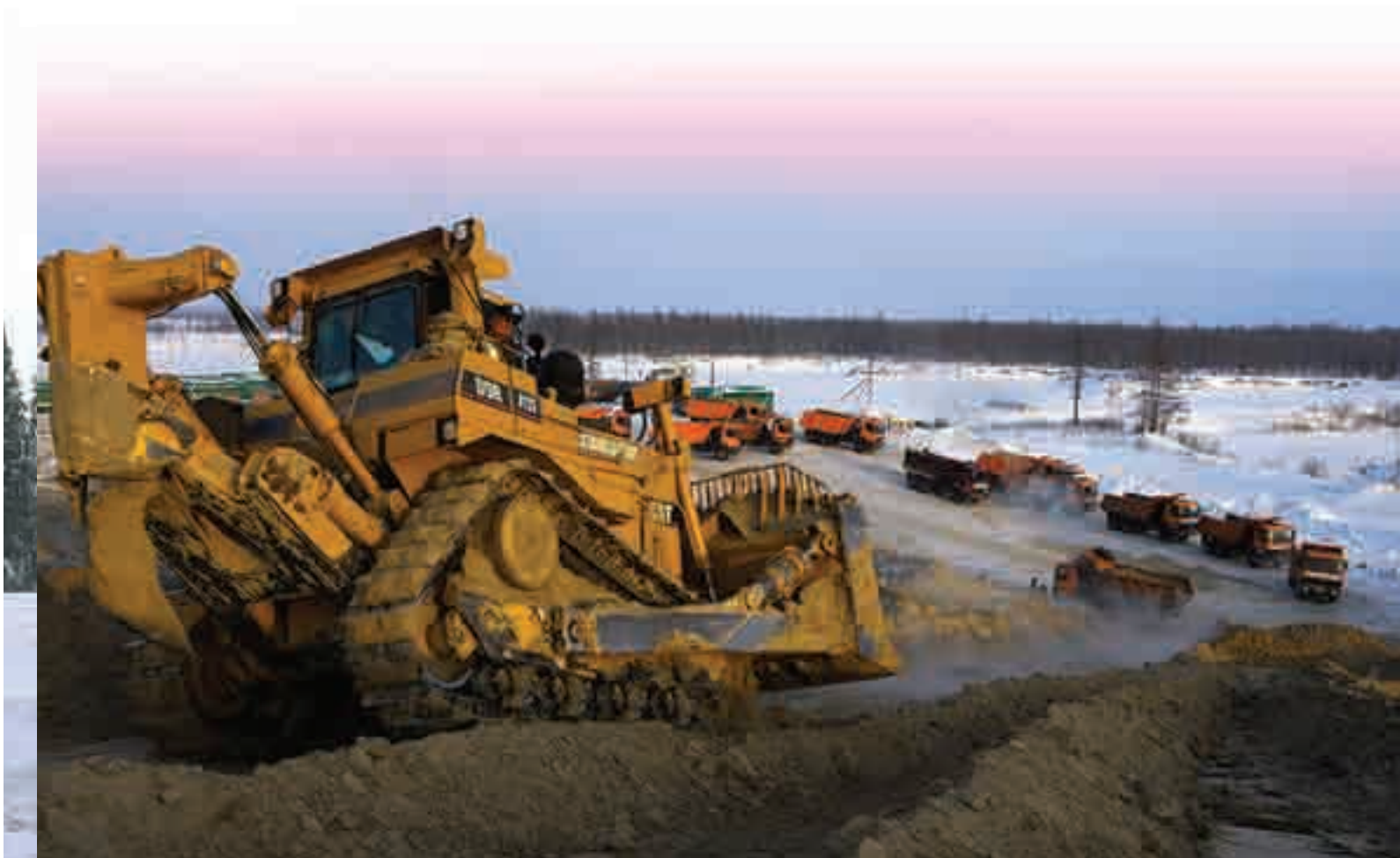
Укладка трубопровода в траншею
