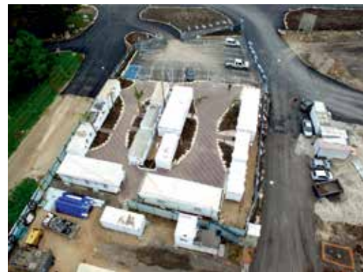
▼ Ситуационный центр EMSolutions на строительной площадке отслеживает параметры всех машин в реальном времени.
