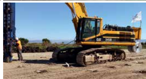
▲ Экскаватор Cat 345B на подготовке территории района Неот Афек.
